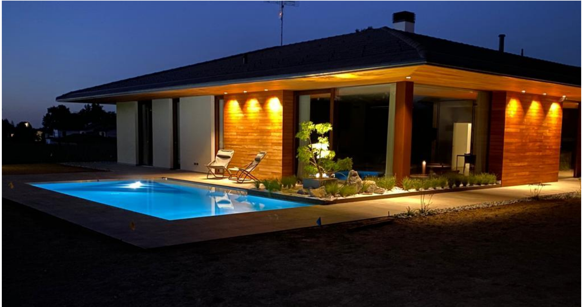
Cuneo – progetto Damilano Studio Architects
